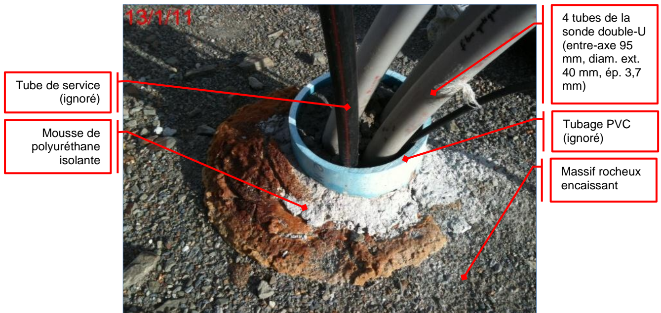
Illustration 12 – Etat de la tête d'un forage d'injection de chaleur
